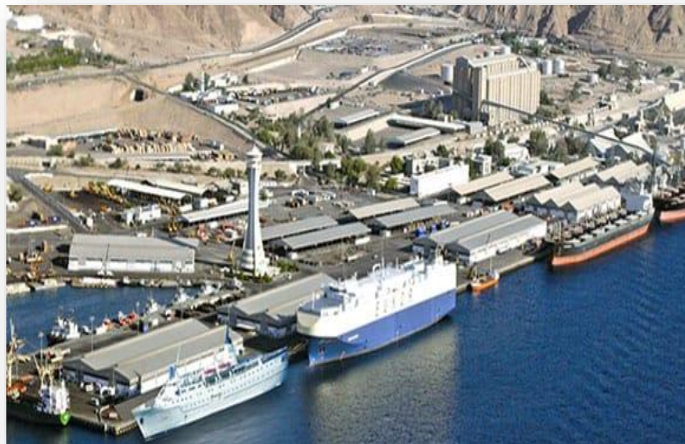
بناء البرج والمكاتب الخاصة بالدائرة البحرية 1991
